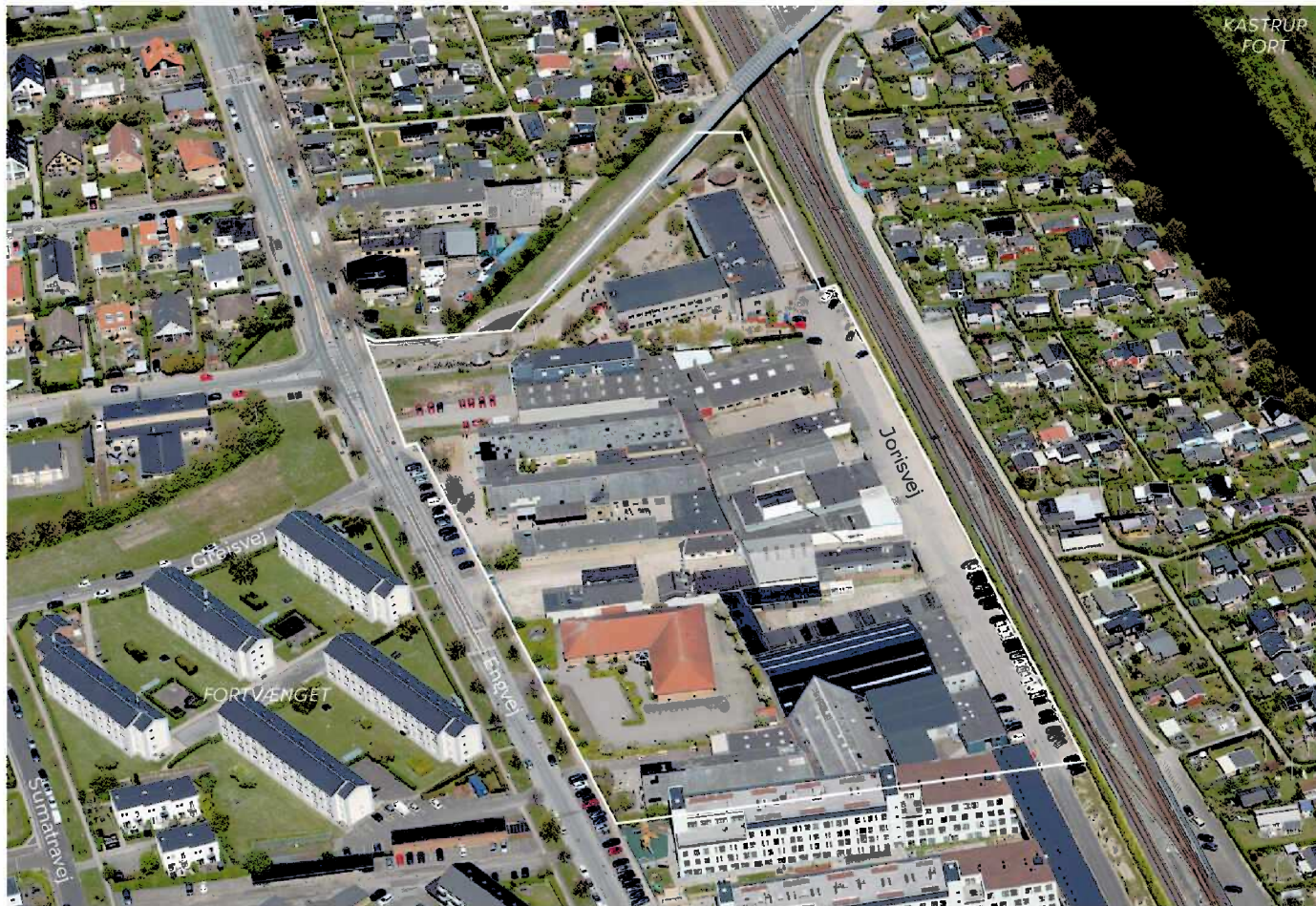
Området set mod nord. Lokalplanområdet er indtegnat med hvid linje, og de vigtigste gader og bygninger er navngivet. Luftfoto: SDFI, 2023.
