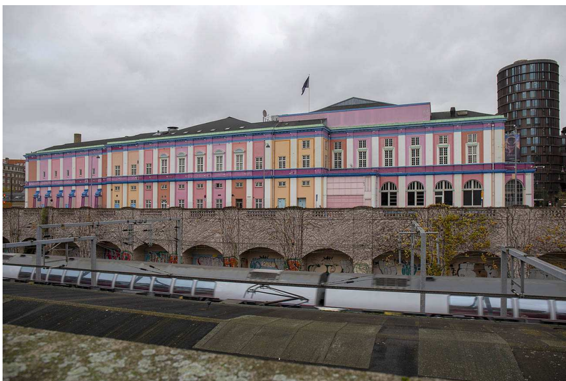
Palads set fra vest, hvor facaden flankerer Hammerichsgade og ses i sin fulde længde hen over Vesterport banegrav.
