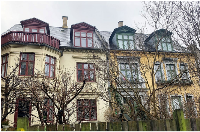
Bevaringsværdige bygninger, Bjelkes Allé nr. 37 (t.v.) og nr. 39 (t.h.).
