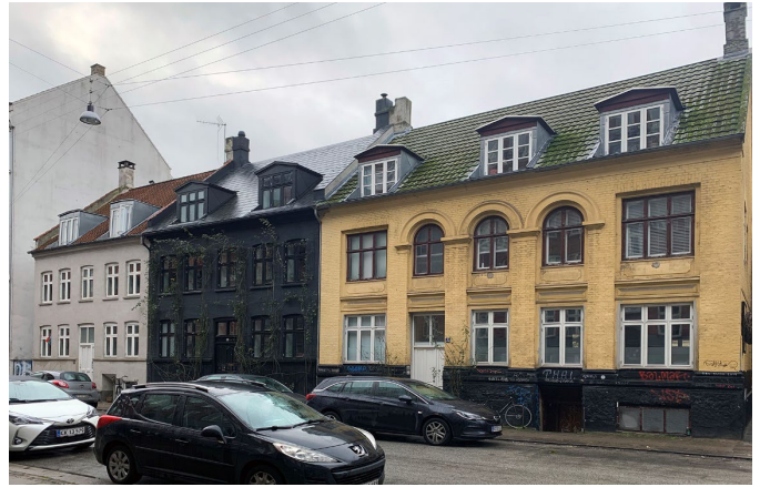
Bevaringsværdige bygninger. De ældste byhuse på Bjelkes Allé; nr. 13 (t.v.), nr. 15 (i midten) og nr. 17 (t.h.).
