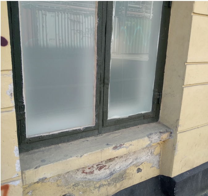
Ejendommen er meget fugtpletet.
