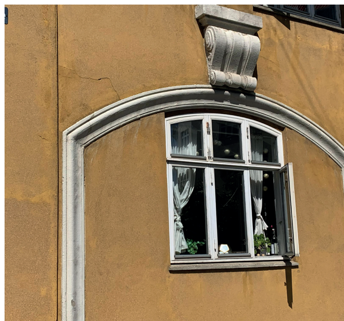
Vinduer udskiftes og facader renoveres.
