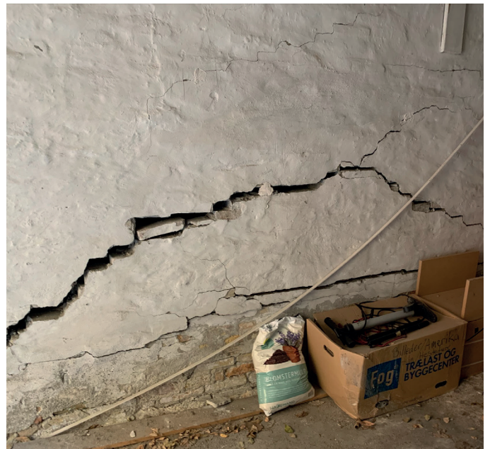
Revner og skader i facader udbedres.
