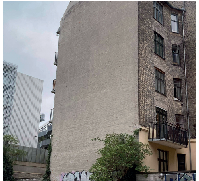
Ejendommens kolde gavle efterisoleres.
