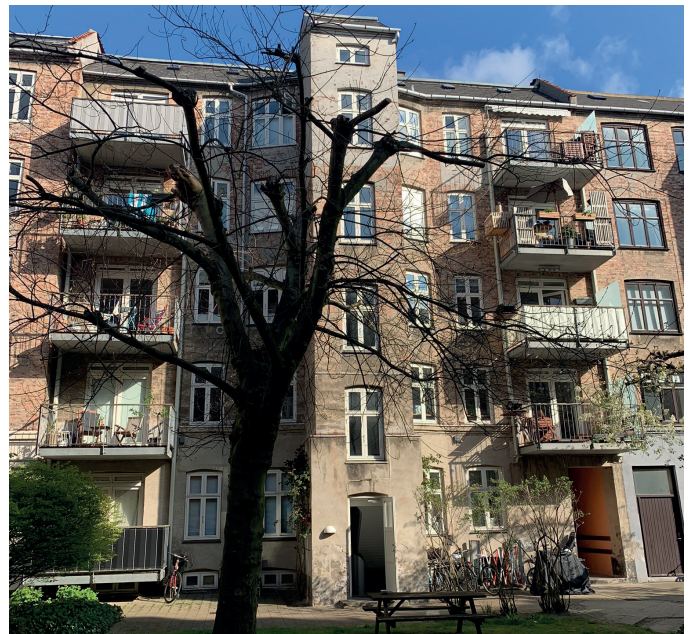
Ejendommen set fra gården. Revner udbedres.
