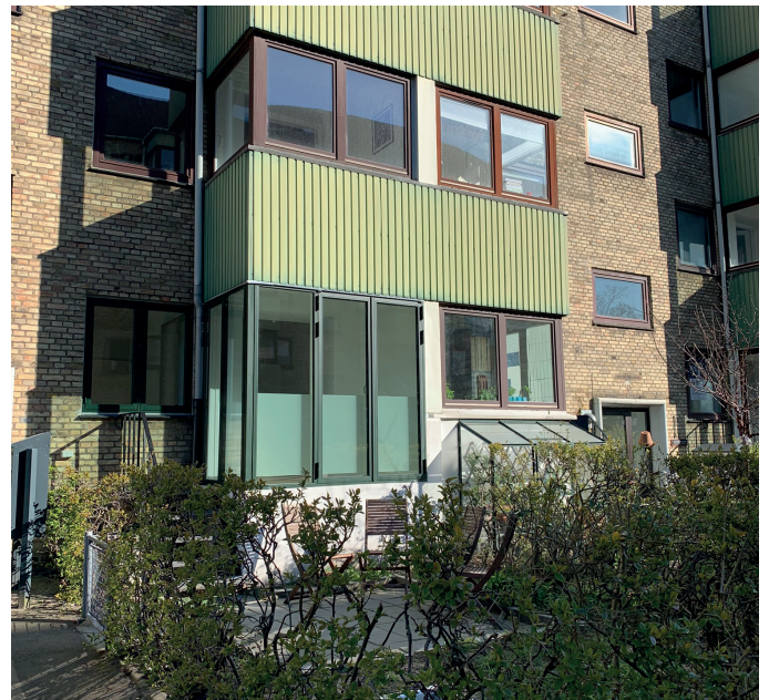
Uisolerede karnapper ombygges og får mere dagslys.
