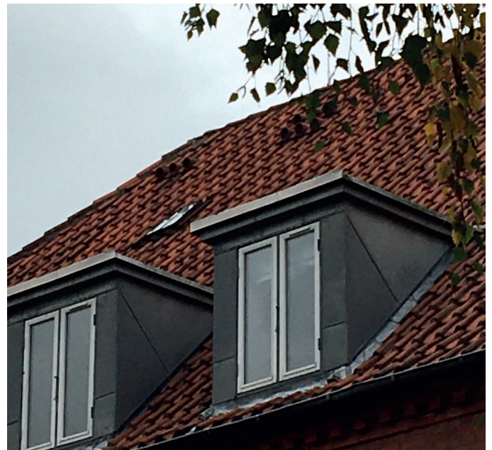
Taget er nedslidt. Boliger i tag efterisoleres.
