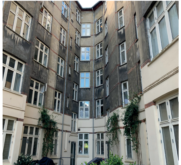
Gårdfacade renoveres og vinduerne udskiftes.
