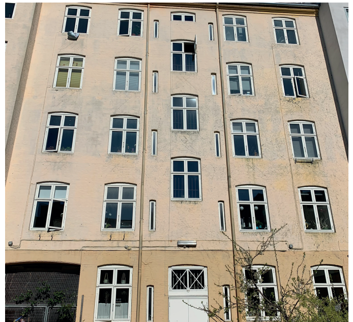
Ejendommens vinduer er utætte og udskiftes.
