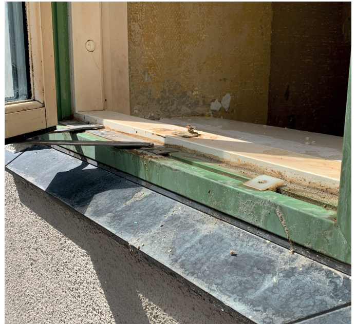
Nedslidte vinduer udskiftes til nye trævinduer.
