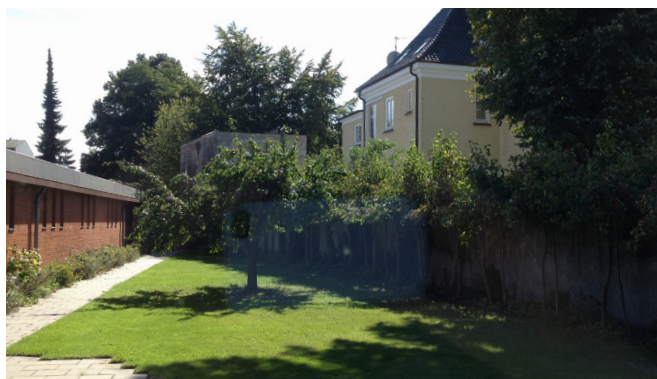
Den lave bygning, der tænkes nedrevet og nabobebyggelsen på Svanemøllevej mod mod vest.
