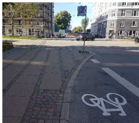
Figur 4. Udposning på fortovet ved Strandboulevarden, som tvinger cyklister ud på vejen for at fortsætte ad cykelbanen på Randersgade.
