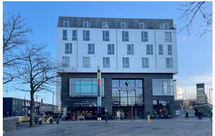
Hovedindgangen til butikscenteret set fra vest på Vanløse Torv.
