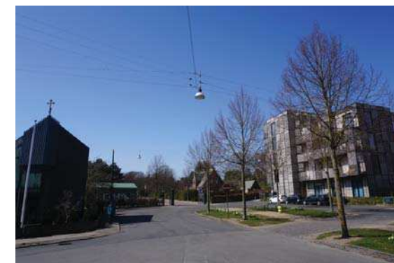
EKSIST. FORHOLD VED FREMTIDIG KVARTERSPLADS
