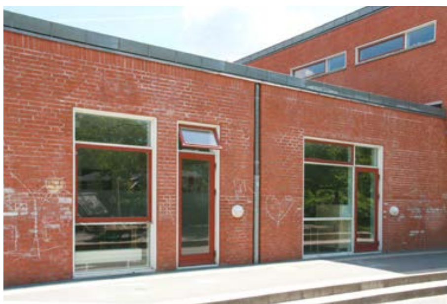
Tilbygningen til skolen fra 2005. Nedløbsrørene er indbygget i muren.
