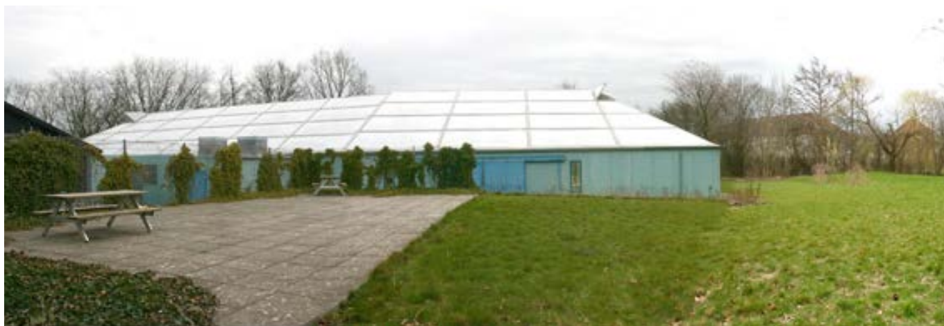
Panorama af området bag Emdrup Badet hvor Byggefelt A og B er placeret.
