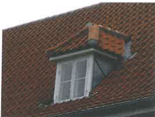
Peter Rørdamsvej 24-28 Saddeltagskvist med flunker inddækket i zink
