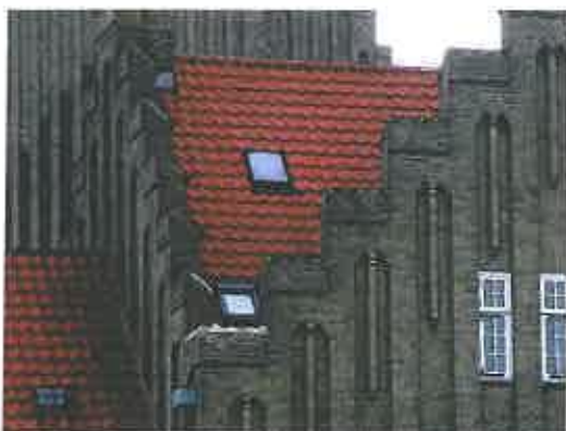
Bispebjerg Torv 10A 2 forskellige typer tagvindue: GVO samt vippevindue
