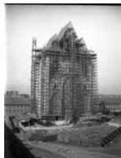
Grundtvigs Kirke kirken under opførelse.
