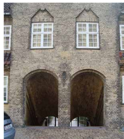
Porte med adgang fra På Bjerget til C. J. Birkedalsvej - bemærk murdekorationer over vinduerne og de murrede buer i portene.
