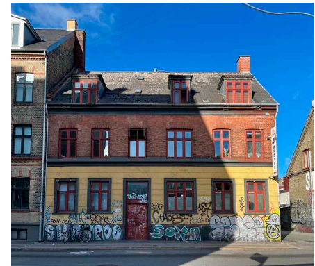
Nordre Fasanvej 273 - forhus.
