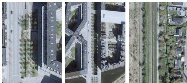
Kanalerne beskytter Ørestad mod oversvømmelser ved at lede regnvand til havnebassinet. Ved høj vandstand opsamler søer og vådområder på Amager Fælled og Vestamager det overskydende vand Kort: Klimadatastyrelsen ortofoto, CC-BY 4.0
