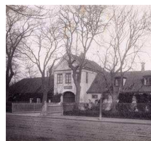
Holmblads Limfabrik 1905. Foto: Frederik Riise, Københavns Museum, ID: 279755
