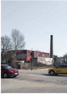
Fabriksbygning og skorsten på hjørnet af Prags Boulevard
