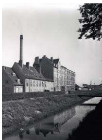
Regnvandskanalen Prags Blvd, ca. 1937 Billede: Firmaet Elfelt, Københavns Museum, CC-BY, ID 305900
