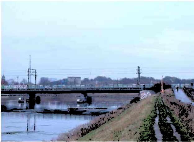
Amagerbroen set fra Dæmningsvej
