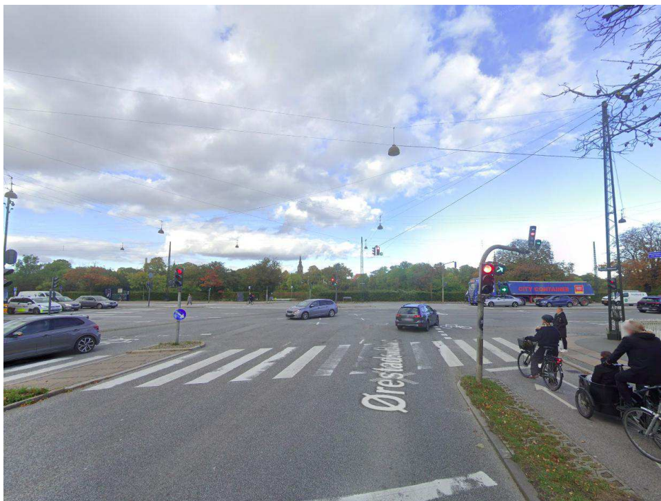
Figur 2-4 Situationsbillede af krydset mellem Ørestads Boulevard og Amager Boulevard.
