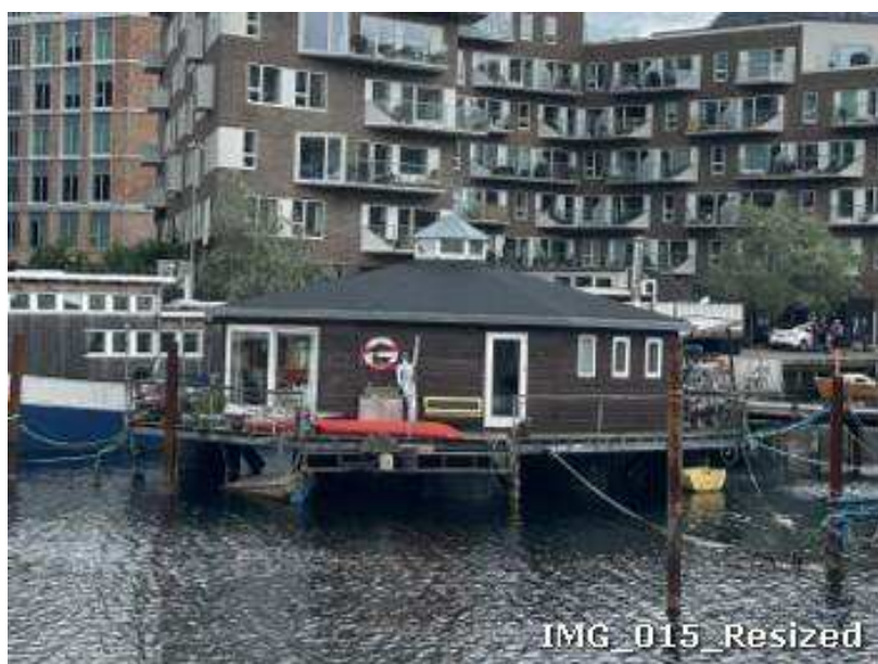
Figur 3-17: Husbåd i Tømmergraven på pælefundament.
