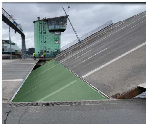
Figur 8: Åbning begyndt. Oversiden af den løse kontravægt, er markeret med grønt.
