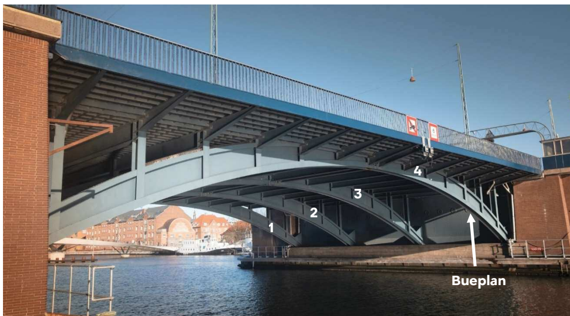
Broklappernes fire bærende bueplaner
