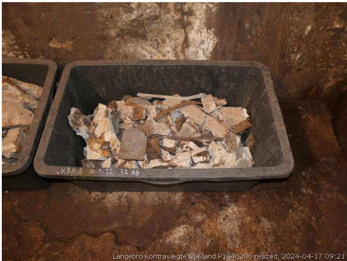
Afskallet beton fra kontravægten opsamlet i spande
