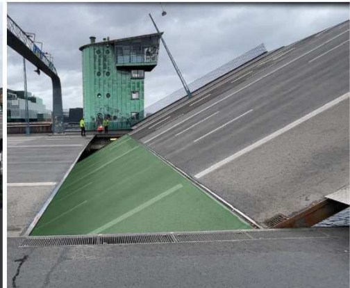
Figur 8: Åbning begyndt. Oversiden af den løse kontravægt, er markeret med grønt.
