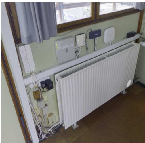
Figur 27: Mindre el-komponenter der flyttes til skab på etagen nedenunder.
