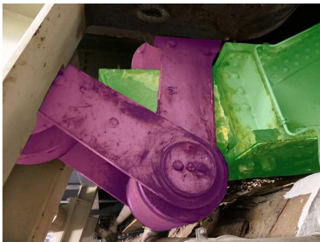
Figur 23: Baskuleringsarrangement. Hornene på den løse kontravægt (grøn) hviler i lukket tilstand på baskuleringsrullerne (lilla), der hænger i de lodrette baskuleringsarme. Når akslen roterer, trækkes armen med baskuleringsrullen væk fra kontravægten, der dermed lægger sig ned oven på den faste kontravægt. (foto).
