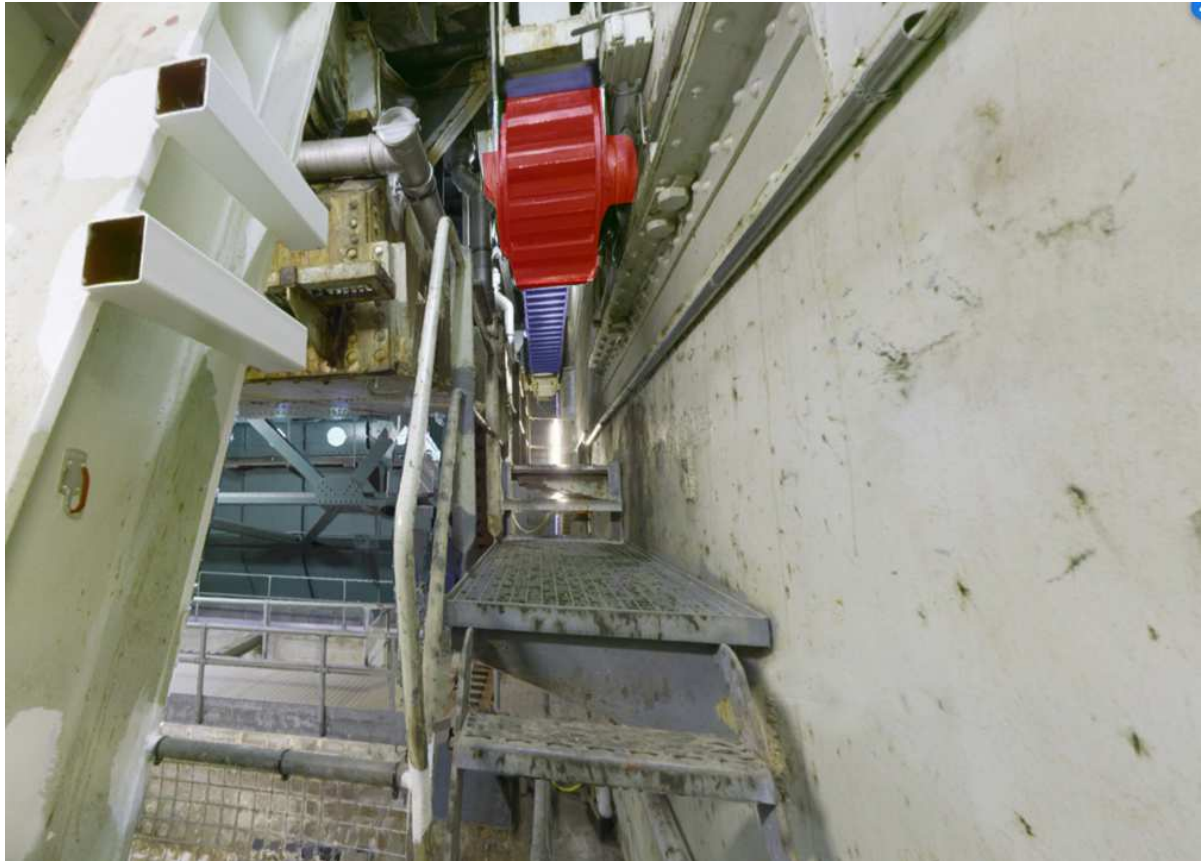
Figur 21: Klapkælder København, syd. Drivhjul (rødt) og tandstang (violet) set fra baggangen skråt nedefra. Foto.
