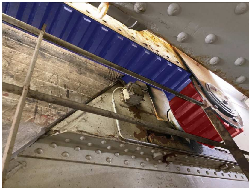
Figur 8: Tandstang (fremhævet med blå) set nedefra.
