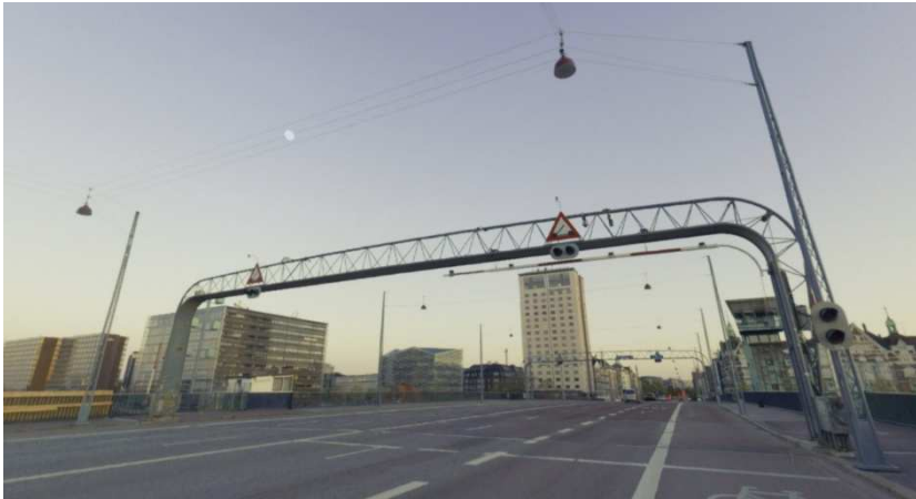
Figur 30: Galger for bomme mv. og de nærmeste lysmaster nedtages midlertidigt.
