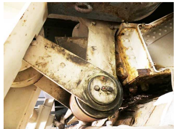
Figur 12: Baskuleringsarme og -rulle (violet farve) samt -horn (grøn farve) i lukket (debaskuleret) tilstand (den løse kontravægt er løftet fri af den faste kontravægt ved at baskuleringsrullen er skubbet ind under hornet. Foto med og uden farvelægning.
