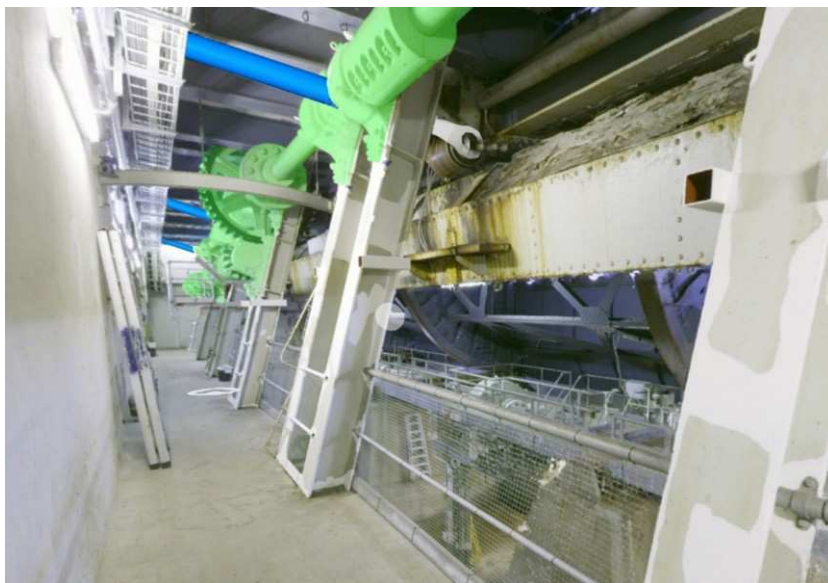
Figur 12: Samme sted som Figur 9. Nye aktuatorer til baskulering er vist med blå, med en hvid gaffel, der griber fat i baskuleringsrullen. De med grønt markerede dele nedtages. Den faste kontravægt, som vil blive udskiftet i forbindelse med renoveringen, jf. pkt. a) er vist som den er, og ikke som den bliver.
