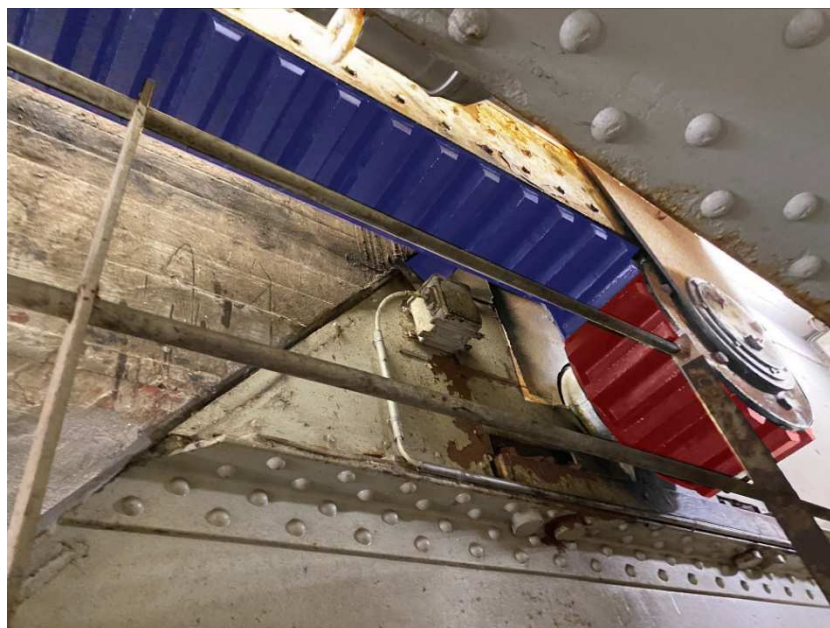
Figur 8: Tandstang (fremhævet med blå) set nedefra.
