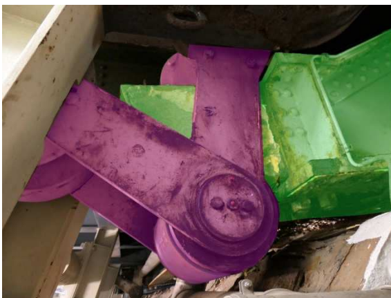
Figur 12: Baskuleringsarme og -rulle (violet farve) samt -horn (grøn farve) i lukket (debaskuleret) tilstand (den løse kontravægt er løftet fri af den faste kontravægt ved at baskuleringsrullen er skubbet ind under hornet. Foto med og uden farvelægning.
