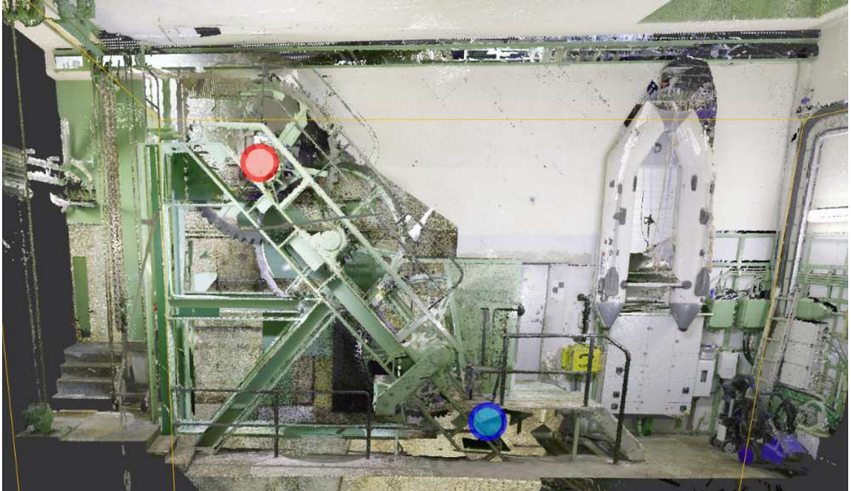
Figur 18 Klappille København. Maskinrum syd, geargalleri. Aksel fra det centrale gear midt i klapkælderens kommer ind forneden (ca. ved den blå cirkel), og gennem tandhjulsudveksling drejer den drivhjulet på den anden side af væggen, monteret på den aksel der er markeret med rødt.
