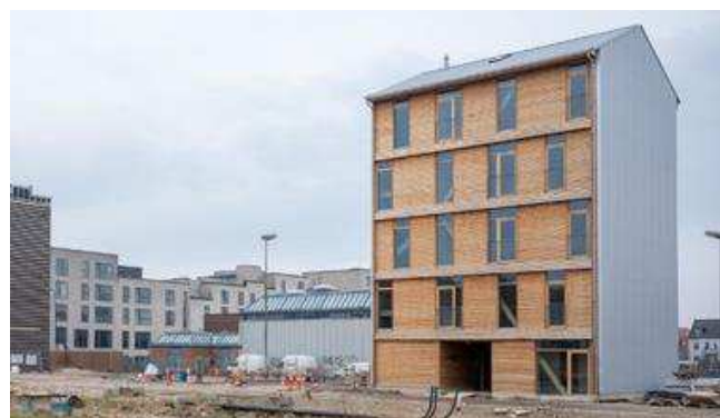
Udviklingsbyggeriet MiniCO2 Etagehus TRÆ har etagedæk af træ kombineret med sand, der anvender 30% mindre træ end gængse CLT-etagedæk. Byggeriets materialer har en udledning på 5,07 kg. CO 2 /m 2 /år, hvoraf etagedækket udgør ca. 12 %. Obs. Tallet kan ikke direkte sammenlignes med LCA, da drift ikke er medregnet. Kilde og foto: Realdania By & Byg, 2024.
