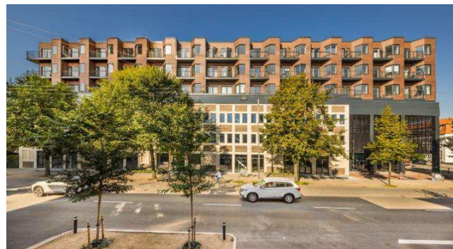
Lygten 37 omfatter både bevaring af eksisterende 6.680 m 2 (inkl. kælder) og tilføjelse af tre etager med 2.925 m 2 . Det vil sige en total 44 % forøgelse af areal. Der er sparet ca. 50 % af samlet CO 2 -udledning sammenlignet med hvis der var bygget tilsvarende nyt. Kilde: Cases, eksempler på genbrug af bærende konstruktioner, Social og boligstyrelsen, 2023. Foto: C.W. Obel Ejendomme.
