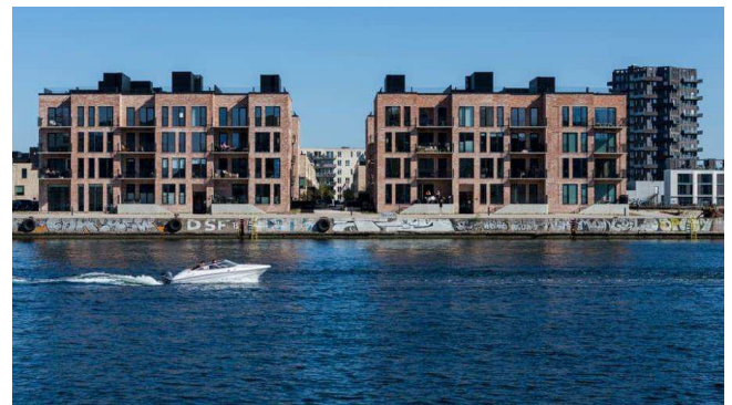
Boligbyggeriet Castor på Islands Brygge benytter spring i facaden til at skabe reliefvirkning og variation langs facaden, som desuden er opført med genbrugstegl. Kilde: Henning Larsen, 2018.
