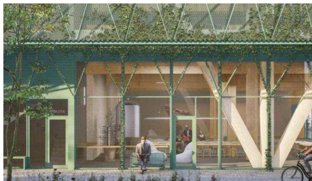
Else Alfelt P-hus i Ørestad: P-huset 'Et hus med fremtid' er designet fleksibelt, med en forhøjet øverste etage og forberedt demontering af 2. sal, så det kan omdannes til bolig eller erhverv. Stueetagen er designet med mulighed for opdeling for at rumme et lokalt 'community hub' med lokale mødesteder, værksteder og muligheder for 'co-working'.
