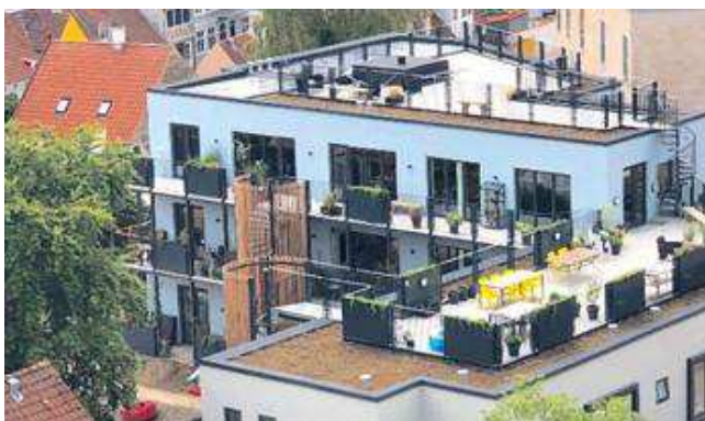
I Byfællesskabet fra 2018 er svalegange og trappe beklædt med klatreplanter, som fungerer som rumdelere og skaber opholdsværdi for beboerne. Kilde: Byggefællesskaber, Realdania, 2019. Foto: Byfællesskabet Effektberegning: Aaen Engineering Datagrundlag: Standard konstruktioner, LCAByg LCA-faser: A1-A3, C3-C4.
