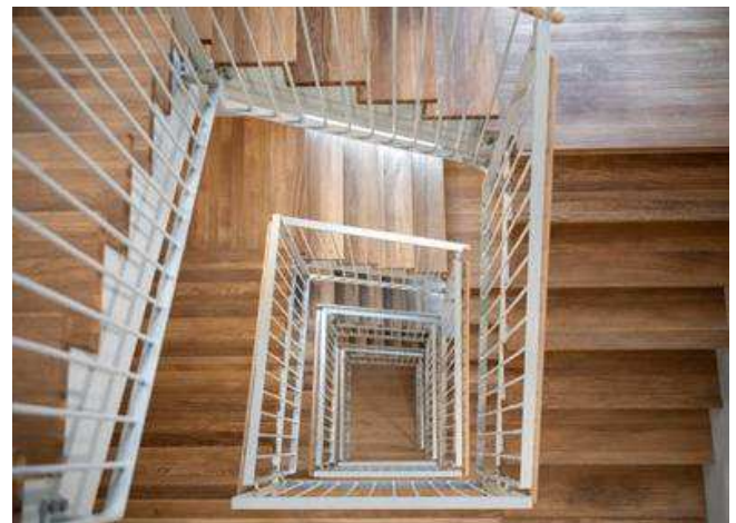
I MiniCO2 Etagehus TRÆ er der anvendt trappekerner i træ og stål. Kilde: MiniCO2 etagehus TRÆ, Realdania By & Byg, 2024.
