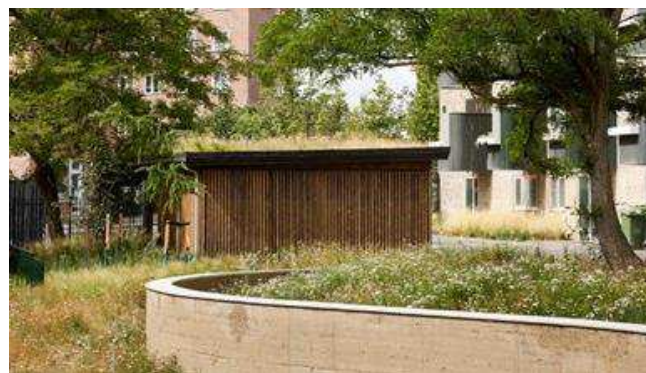
På Tomsgårdsvej er et beplantet landskab med forsinkelsesbassin samt skure med grønne tage med til at sikre regnvandshåndtering på overfladen og et grønt udtryk i gårdrummet. Kilde: Fremtidens Gårdhave ved Tomsgårdsvej, SLA, 2022.
