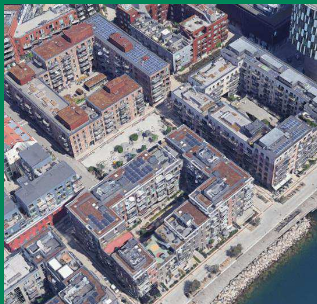
De nye bykvarterer. Fra 2000 og frem. 5-9 etager. 10-12 m dybde + altaner. Varierende størrelser. Flade tage, Springende højder. Bygget på én gang.
