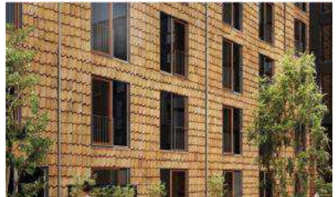
I forbindelse med byggeriet Teglgården blev 12.900 vingetegl nedtaget fra en eksisterende bygning og gemt. Det lykkedes at genbruge 1/3 af stenene 1:1 i nybyggeriet. Resten blev nedknust. Kilde: PensionDanmark, 2022.
