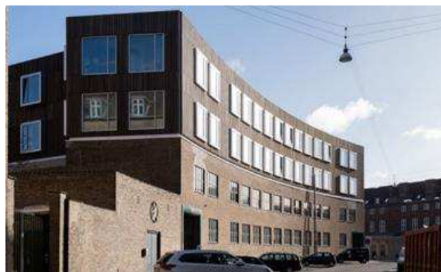
I Hermodsgade er en fabriksbygning omdannet til ungdomsboliger. To etager er bevaret, og der er tilføjet to etager i trækonstruktion med solceller på tag. Det eksisterende murværk er renoveret med genanvendelse af genbrugte mursten og udførelse af efterisolering. Bygningen har SAVE-værdi 3. Foto og kilde: Holscher Nordberg, 2021.
