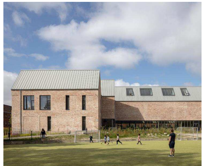
Ved renoveringen af Grøndalsvængets Skole blev ovenlysvinduer brugt til at sikre tilstrækkeligt dagslys i de nye skolefaciliteter. Kilde: VELUX og JJW Architects, 2019.
