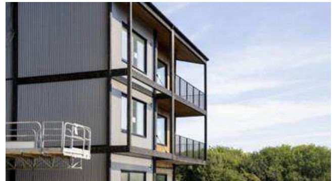
I Fælledby på Amager er byggefelt C6 opført i 3-6 etager i moduler med bærende konstruktioner i træ. Byggeriet har en udledning under 7,5 CO 2 /m 2 /år. (Scandibyg, 2024).
