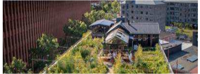
På Østerbro er en ældre bygning med overdimensionerede konstruktioner anvendt til tagfarm. Dette er oplagt i et scenarie, hvor bygningen alligevel er konstrueret til at kunne bære mere end dets nuværende funktion.
