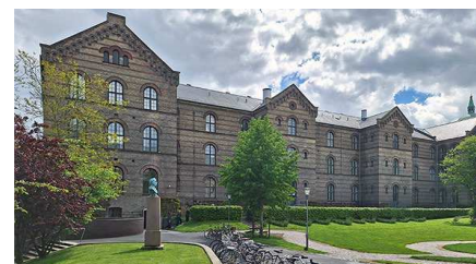
Hovedanlæg, Mandehaven med bygning 4.
