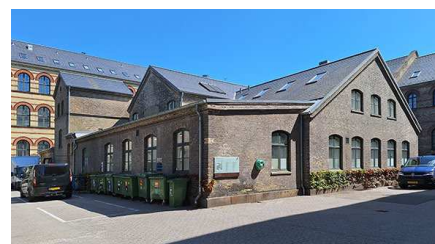
Bygning 20. Kedel- og maskinhus.
