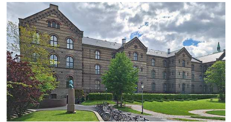
Hovedanlæg, Mandehaven med bygning 4.
