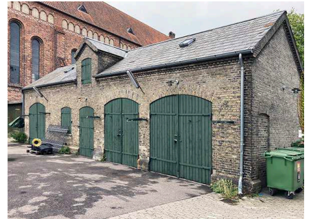
Bygning 11. Stald og gartnerbolig.
