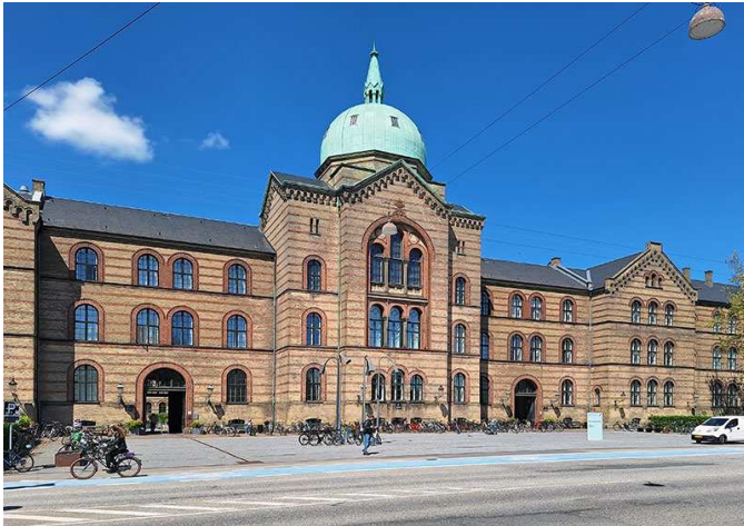
Hovedadgangen til hospitalsområdet sker fra den store forplads ved Øster Farimagsgade. I den fremskudte midterbygning er der kirke, og der var også oprindeligt operationsstuer. På hver side af midterbygningen er der adgang til området gennem de to symmetrisk placerede porte.
