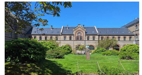
Hovedanlæg, Centralgård med haveanlæg oven på bunker set mod bygning 12.
