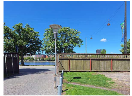
Øster Søgade, som ses her med Sortedams Sø i baggrunden, er en vigtig trafikåre i København og håndterer en stor mængde trafik. Området er heget med plankeværk og mure, der er fredede.
