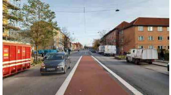
Frederikssundsvej er bred og domineret af kørebaner.
