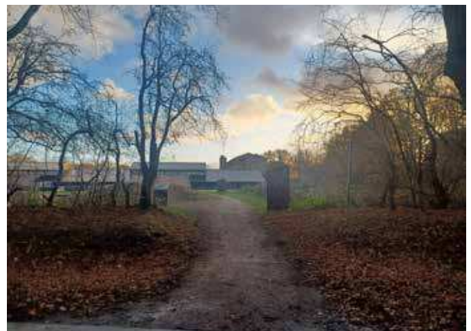
EnergiCenter Voldparken ligger ud til Vestvolden og ankomsten er via en grussti.
