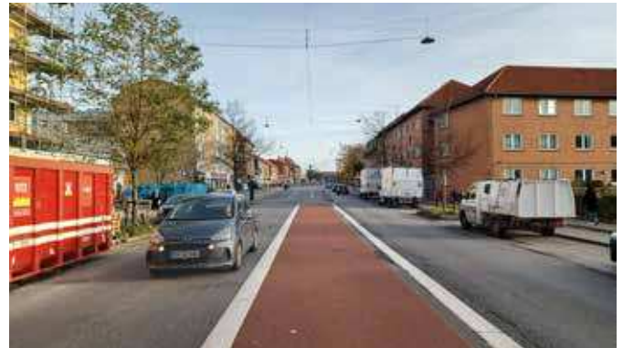
Frederikssundsvej er bred og domineret af kørebaner.
