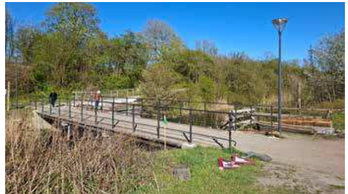
En nyrenoveret gang- og cykelbro krydser Vestvolden ved Bystævnet.
