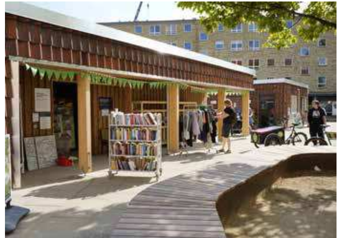
Helga Larsens Plads Nærgenbrugsstation fra 2025 er bygget af mere end 50% genbrugte og genanvendte materialer.
