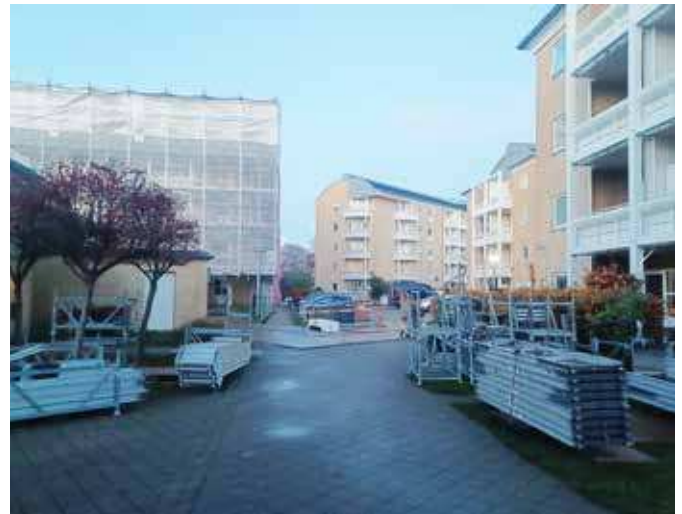
Husumgård blev renoveret i 2023-2025. Billedet viser, hvordan bygge- og anlægsarbejdet påvirker området mens renoveringen står på.
