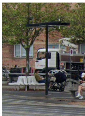
Effektbelysning på lav mast – to cirkler med nedadrettet lys
