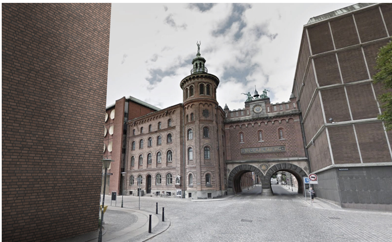
View 2: Lagerkælder 3 og Maltmagasinet - eksisterende forhold - set fra Ny Carlsberg Vej. Facaden på den kommende Europaskolen er vist skematisk til venstre i billedet. Illustration: Arkitema.
