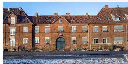
23. Kontor- og administrationsbygning.
