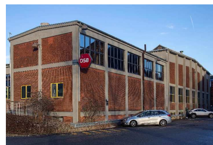
19. og 20. Værksted og Eftersynshal.
