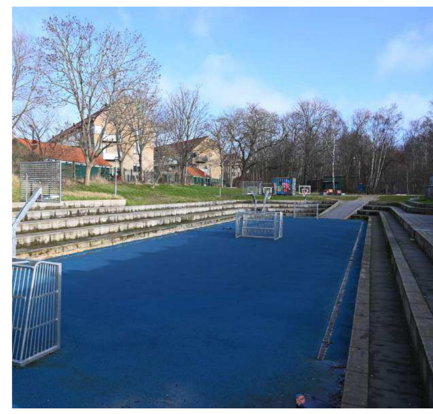
Multibane i skybrudssikringsbassin
