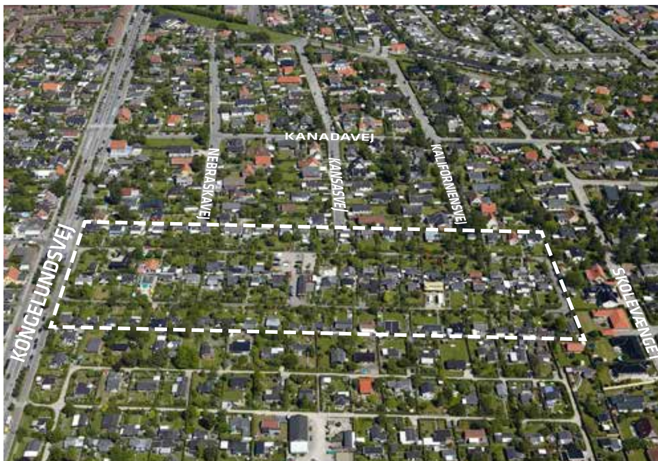
Luftfoto af lokalplanområdet i juli 2012. (JW Luftfoto).
