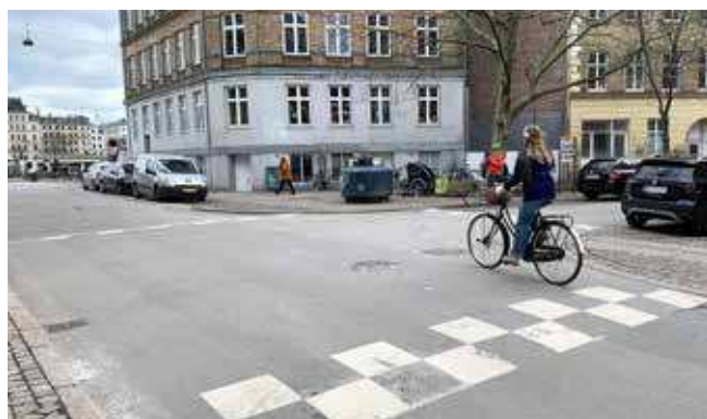
Hævet flade, Wesselsgade/Baggesensgade
