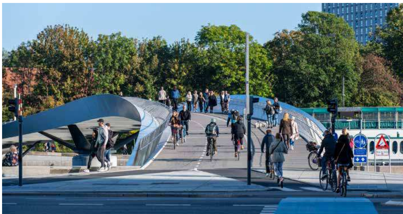
Lille Langebro, foto Troels Heien
