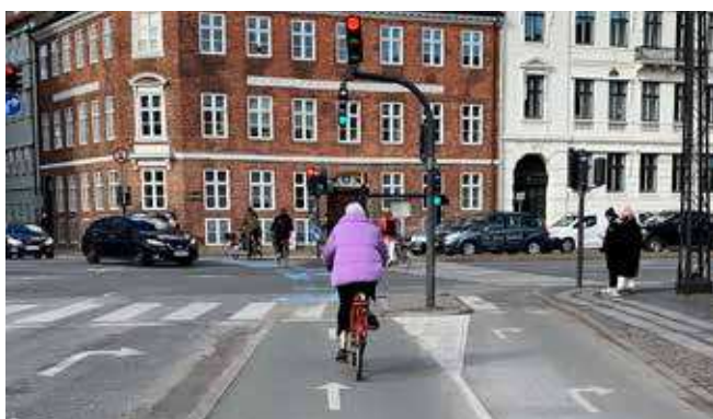
Fremført cykelsti med separat regulering, Havnegade/Holmens Kanal
