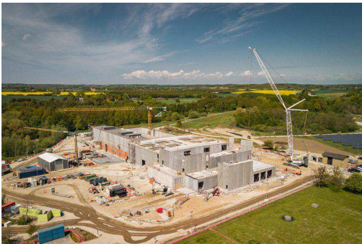
Figur 2. Byggeriet har for alvor taget fat i takt med at betonelementbyggeriet pågår (foto fra øst mod vandværket, maj 2026)
