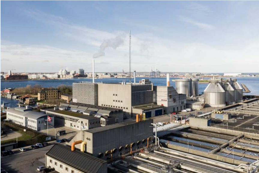
Renseanlæg Lynetten, uden overdækning
