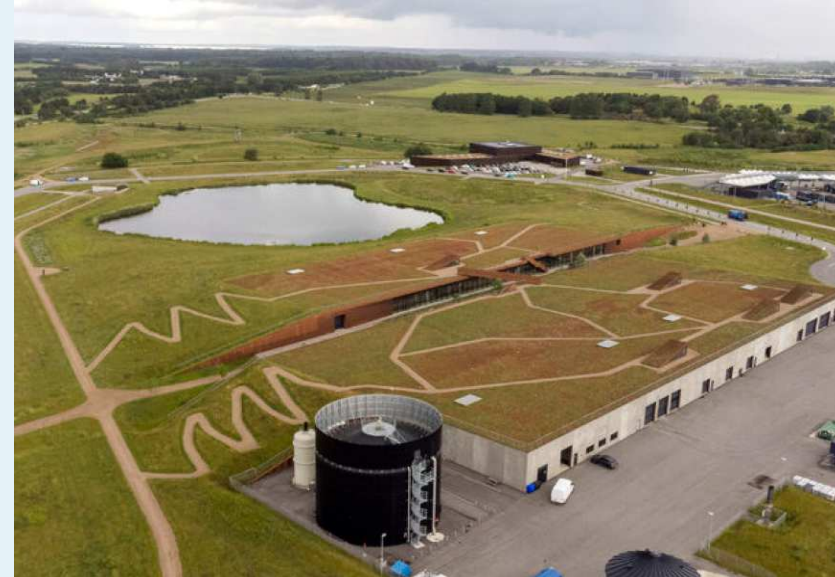
Hillerød Forsyning m. overdækning
