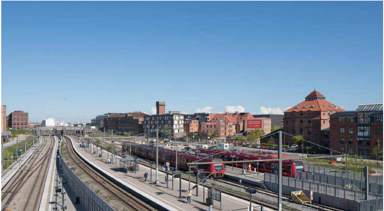
Figur 8.1: Foto af planområdet fra en sydøstlig retning. Den bevaringsværdige bygning, Sukkertoppen og Skandinavisk Henkel med tårnet i baggrunden.
