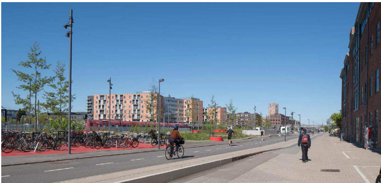
Figur 9.1: Foto af planområdet fra hhv. en nordvestlig retning (øverst) og en sydøstlig retning (nederst).
