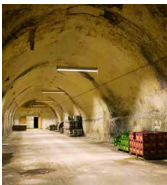
Kælderen under Rød Lagerbygning.
