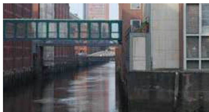
HAMBORG HAVN, Bygningerne danner kystsikring
