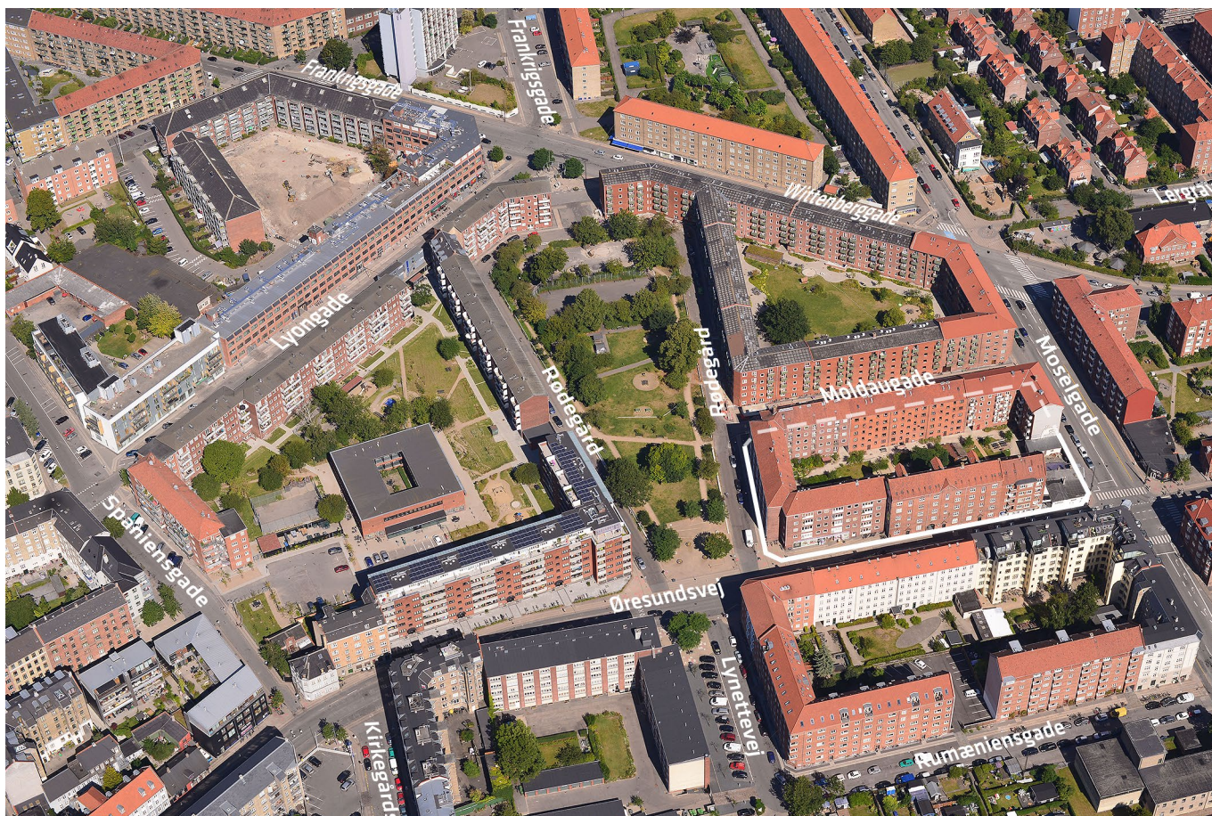
Luftfoto af lokalplanområdet og kvarteret. Lokalplanområdet er markeret med hvid linje. Foto: Københavns Kommune.
