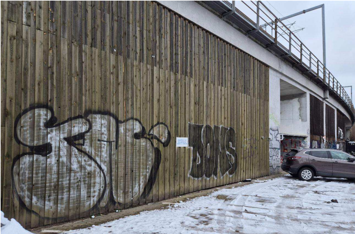
Figur 14 Bræddevæg der lukker for det eksisterende sporvognstracé på EI-forbundets grund.
