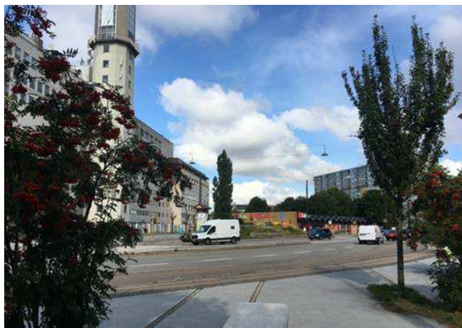
Hjørnet af Borups Allé og Lundtoftegade set fra Borups Plads. Den ét-etages dagligvarebutik er beliggende ud til krydset med et lille bunkeranlæg foran.
