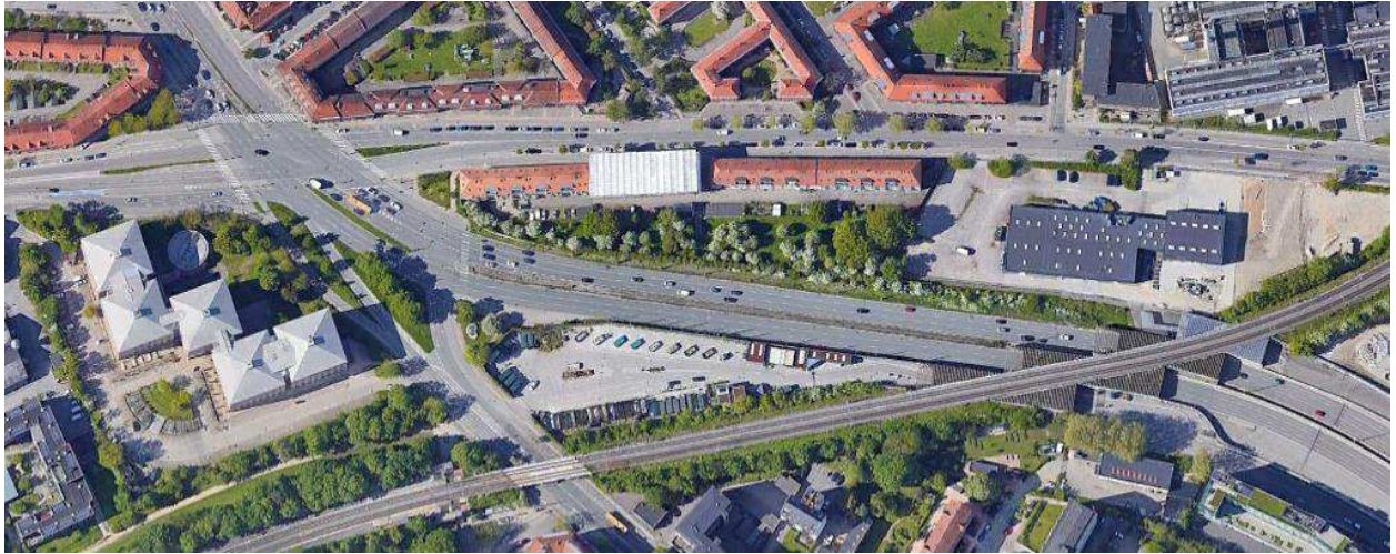
Figur 6-1 Hillerødgade, Bispeengbuen og Ringbanen
