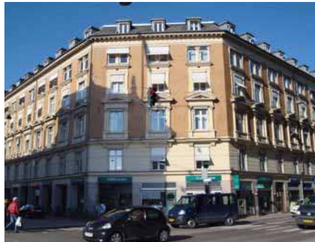
Hjørneejendommen Gothersgade/Store Kongensgade er et eksempel på Type 4.
