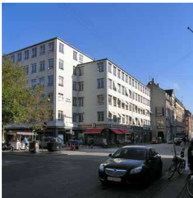
"Borgergadehus". Eksisterende forhold.
