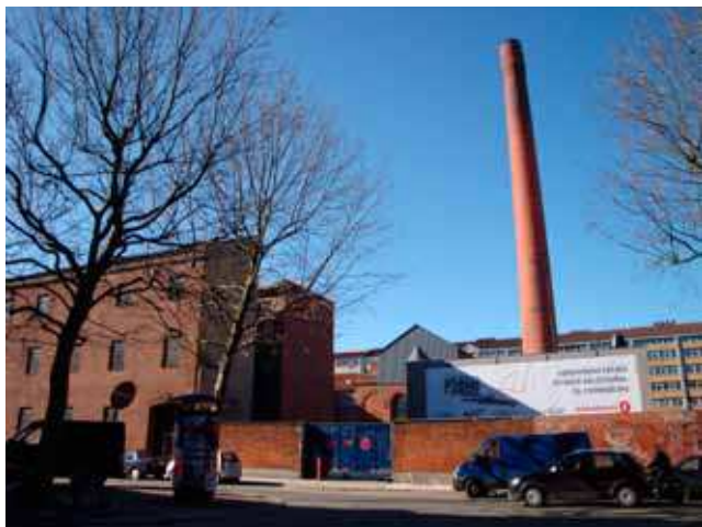
Elværksgrunden i Borgergade overfor lokalplanområdet.
