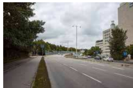
F Rampeopkørsel ved Borups Plads
