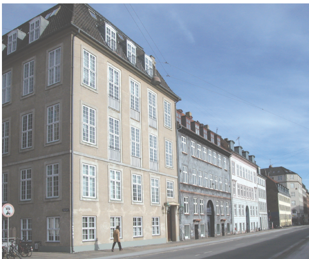
Karreens facade mod Sølvgade. De to 3½ etages porthuse er fredet. Lokalerne i høj kælder anvendes til forskellige erhverv. Karreens bebyggelse er generelt velholdt.
