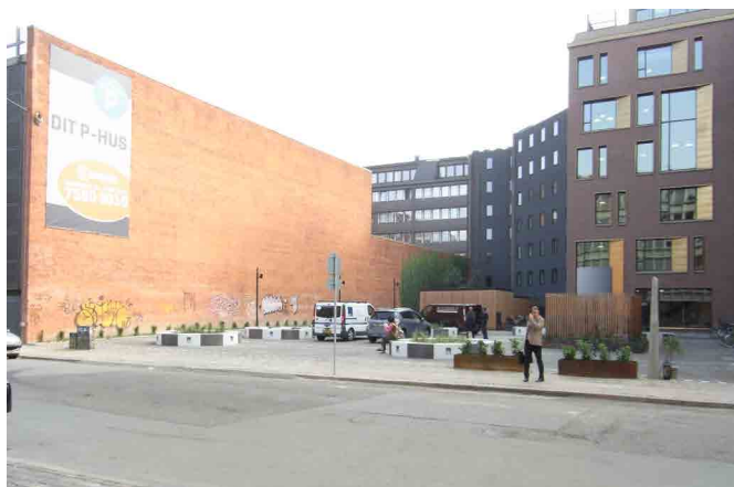
Adelgade med den nye plads ved Turbinehuset
