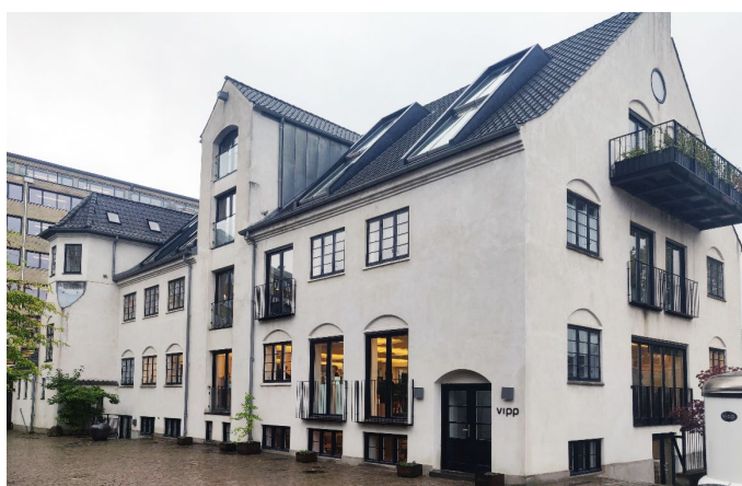
Snorresgade 22, bygningen som huser firmaet Vipp set fra gården.
