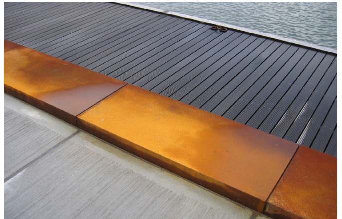
Referencefoto - Beton og trædæk. Illustration: GOTTLIEB PALUDAN ARCHITECTS.
