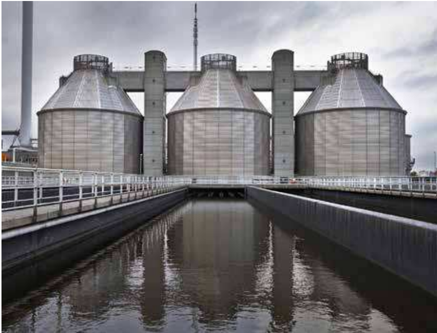
Renseanlægget Lynetten er med til at levere biogas til HOFORs bygasnet. Biogassen, der produceres fra renselanlæggets spildevand, er 100 pct. CO 2 -neutral og udgør en tredjedel af den samlede bygasforsyning.
