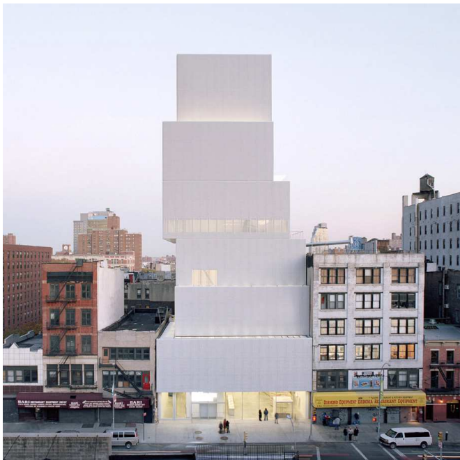
Referencefoto jf. § 6, stk. 9. Eksempel på bygning, der nyfortolker siloernes karakter. Foto Dean Kaufmann New Museum of Contemporary Arts, New York, ark. SANAA
