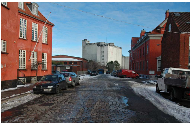
Århusgade med de bevaringsværdige siloer og bebyggelsesmiljøer
