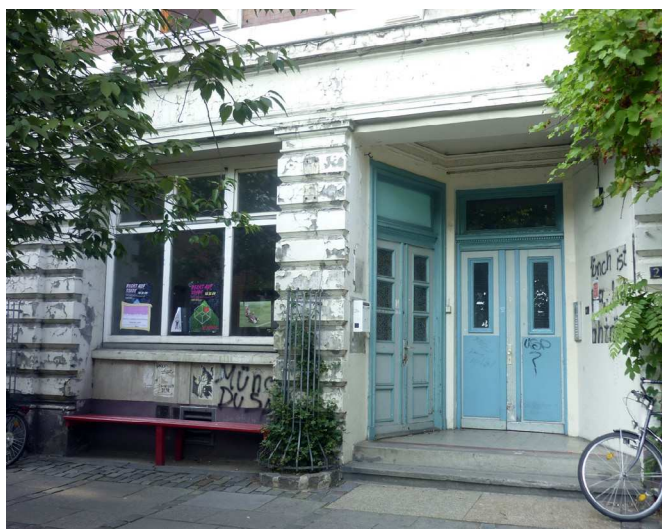
Eksempel på en halvprivat zone i overgangen mellem bygning og byrum. Her indrettet med ophold, beplantning og et markant indgangsparti. Hamburg
